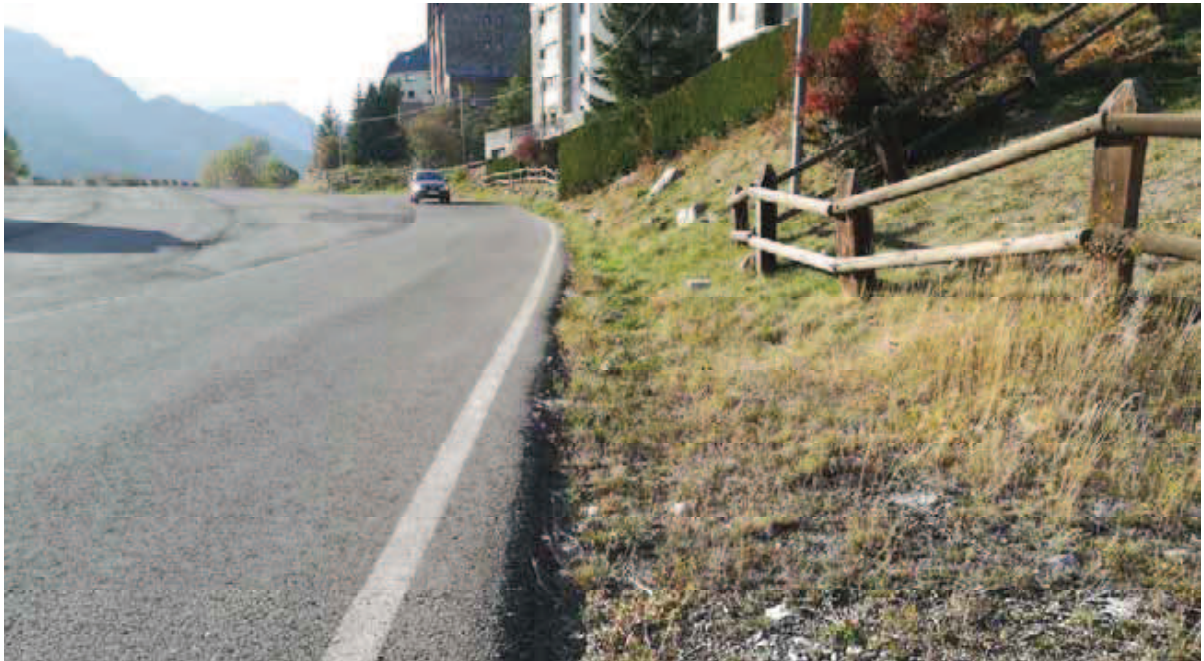
Fotografía 4. Estado de la margen derecha de la calle Sallent a su paso por la UE-1.
