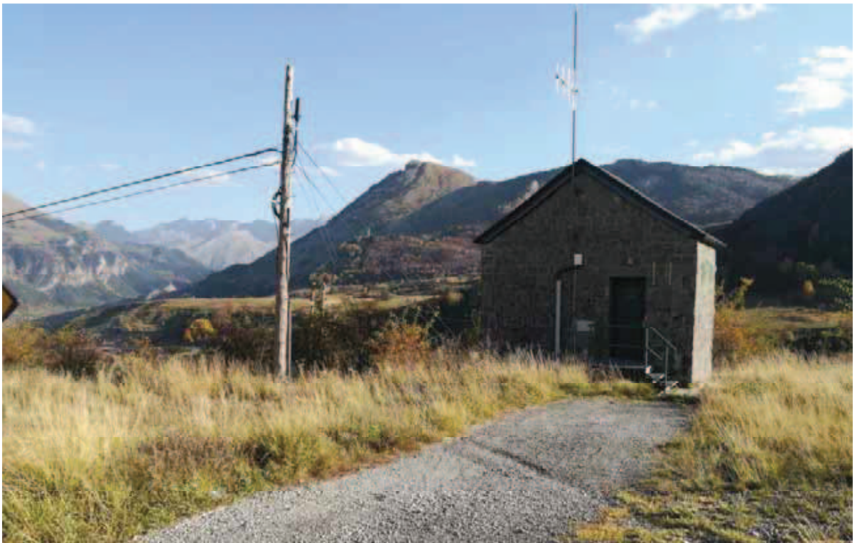
Fotografía 3. Edificio de telefonía, postes y línea aérea existentes.
